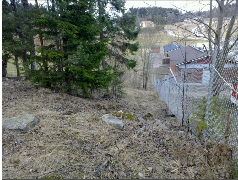
Lämpökeskuksen eteläpuolta putkilinjan kohdalta länteen.
